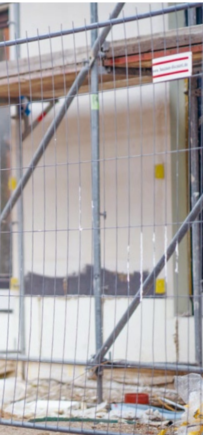
Gemeinsame Baustellenbesichtigung der Vorstände
