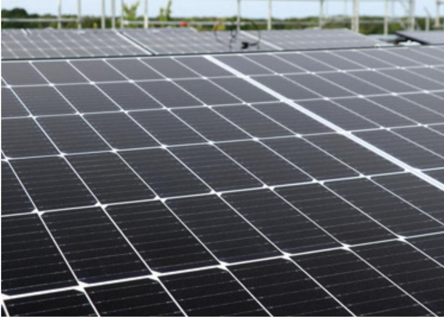
Die Photovoltaikanlage besteht aus insgesamt 130 Modulen, die einzeln auf dem Dach montiert wurden.
