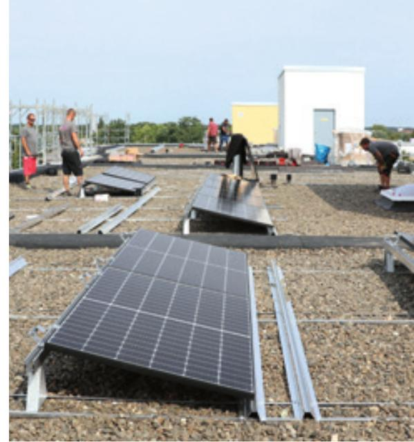
Die Module werden mit Hilfe von speziellen Stützvorrichtungen in den optimalen Sonnenwinkel gebracht.
